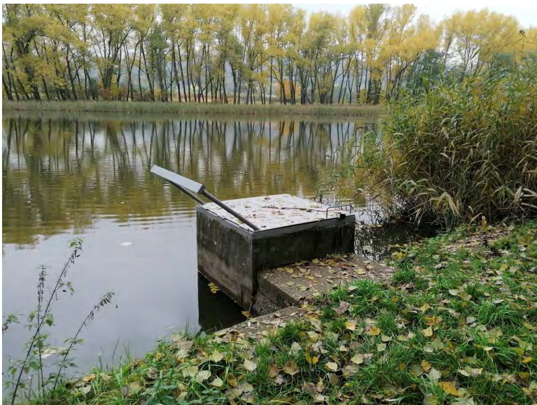
Obr.č. 24 Výpustné zařízení nádrže R5
