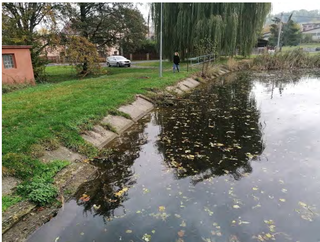
Obr.č. 34 Nádrže R7 – opevnění břehů panely
