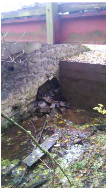
Obr.č. 39 Nádrže R8 – porušené opevnění opěrné zdi přelivu
